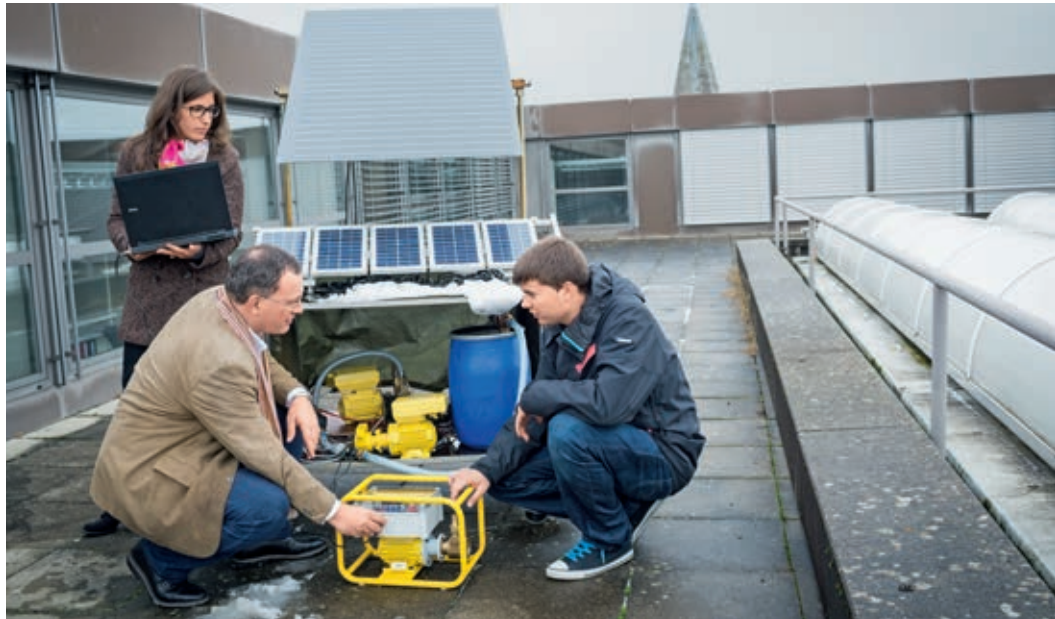
Vom Dach der BFH-TI in internationale Einsatzgebiete: Lukas Menzi, Karin Imoberdorf und Prof. Dr. Andrea Vezzini zeigen, dass die Solarwasserpumpe auch bei bewölktem Himmel in Biel voll einsatzfähig ist.
