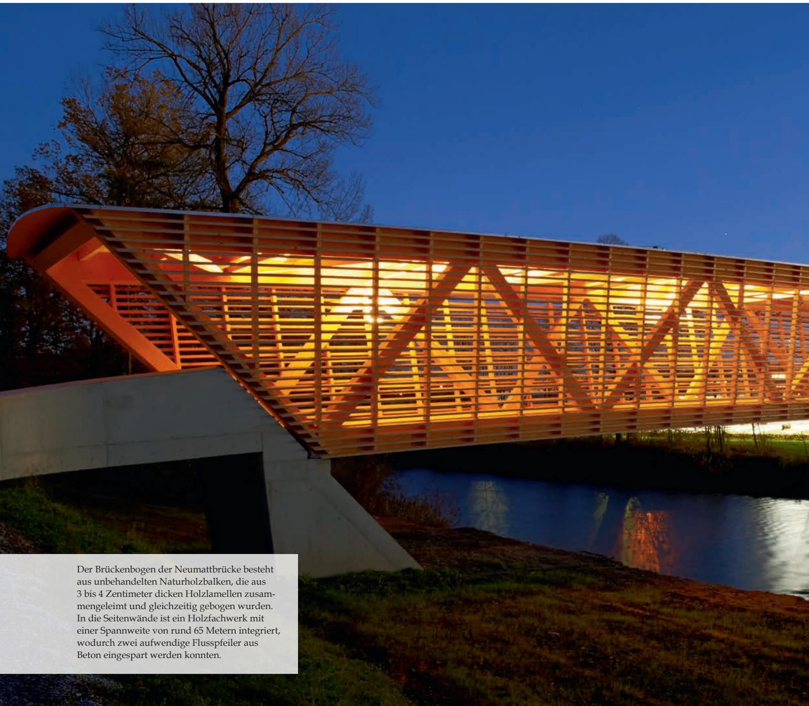
Der Brückenbogen der Neumattbrücke besteht aus unbehandelten Naturholzbalken, die aus 3 bis 4 Zentimeter dicken Holzlamellen zusammengeleimt und gleichzeitig gebogen wurden. In die Seitenwände ist ein Holzfachwerk mit einer Spannweite von rund 65 Metern integriert, wodurch zwei aufwendige Flusspfeiler aus Beton eingespart werden konnten.
