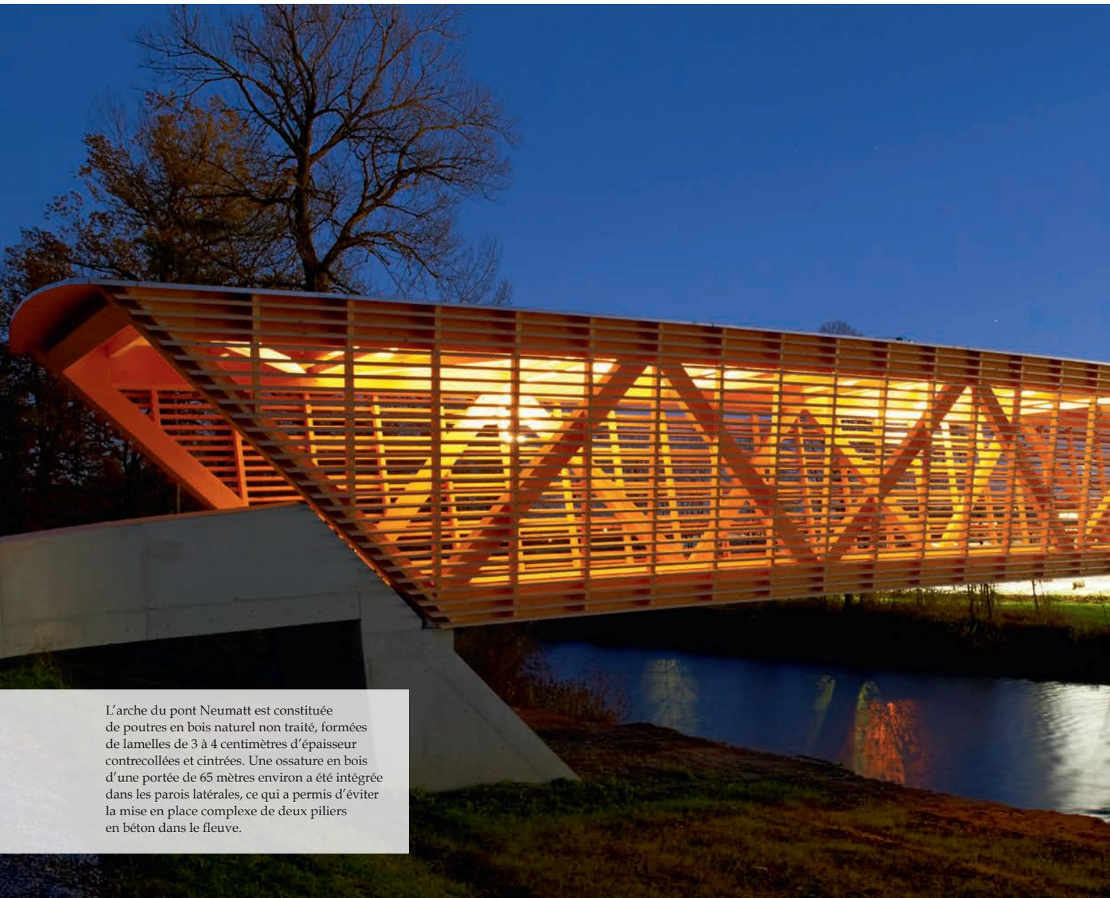
L'arche du pont Neumatt est constituée de poutres en bois naturel non traité, formées de lamelles de 3 à 4 centimètres d'épaisseur contrecollées et cintrées. Une ossature en bois d'une portée de 65 mètres environ a été intégrée dans les parois latérales, ce qui a permis d'éviter la mise en place complexe de deux piliers en béton dans le fleuve.
