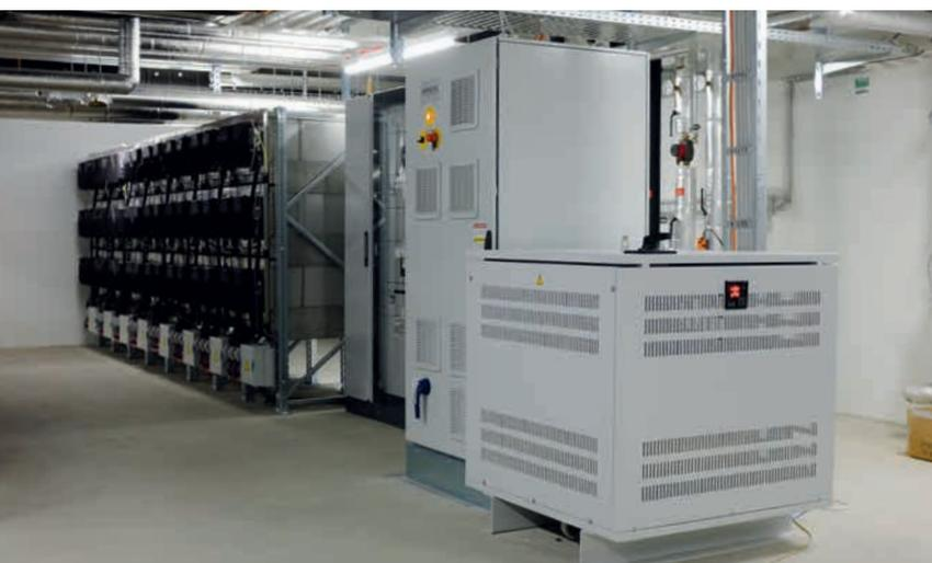
L'accumulateur d'électricité au sel de la Migros à Schlieren ZH d'une capacité de 540 kWh.
